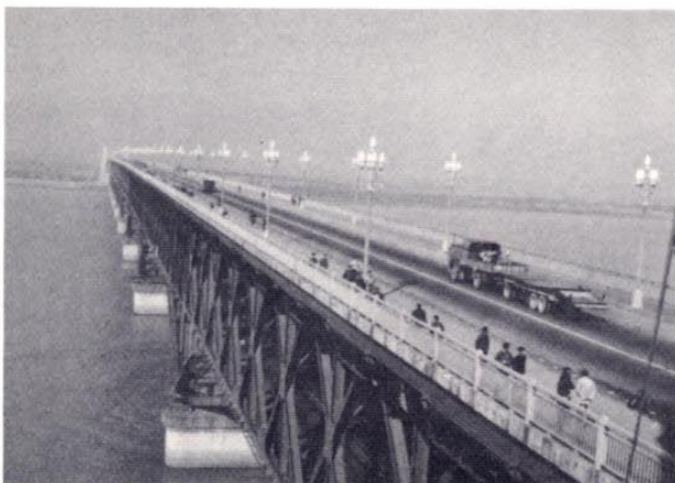
中国が世界に誇る、南京の長江(揚子江)大橋 上段は人・車道で4,500メートル。下段は鉄道で6,700メートル。
